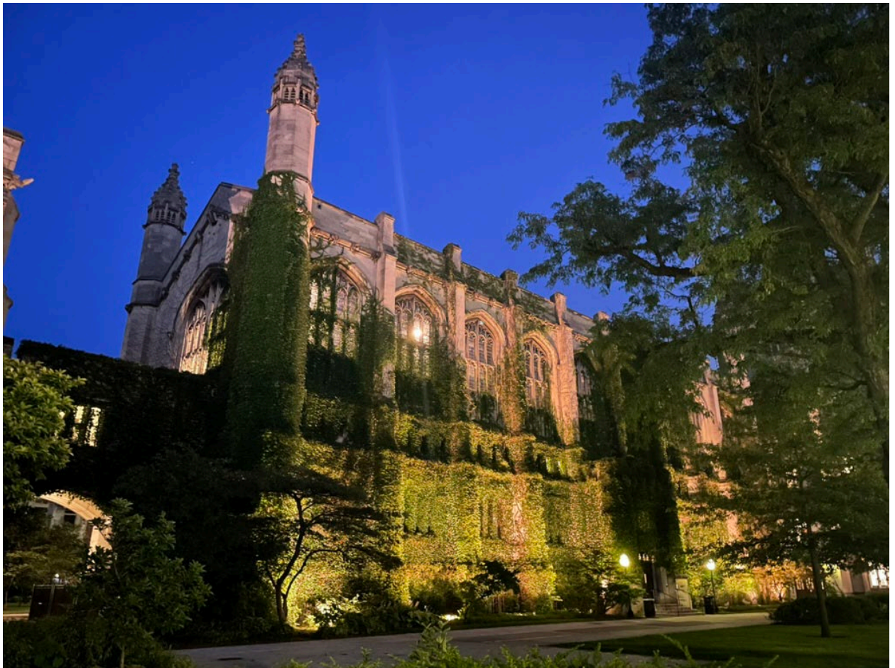
シカゴ大学 Main Quadrangle エリア コンピュータサイエンス棟はもっとモダンな建物だった。
